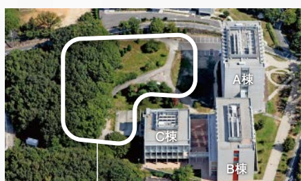
理工学部移転に伴う研究教育棟ならびに情報センター関連施設建設予定地
